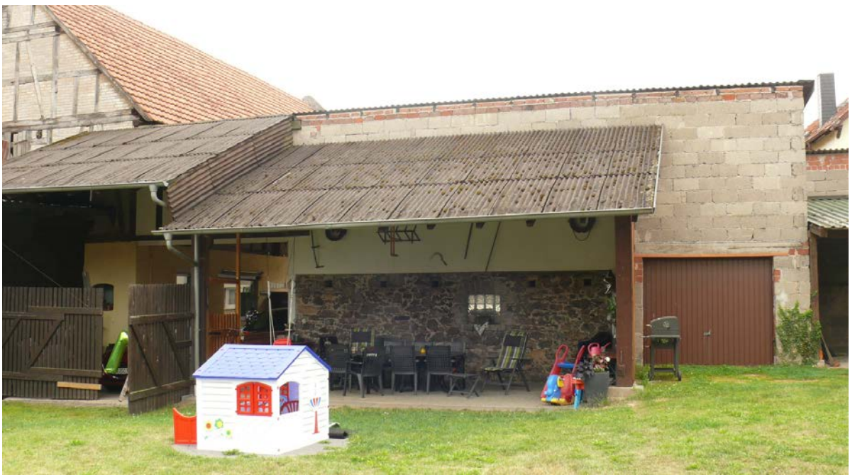
Abbildung 6: Bestehende Überdachung zum Gartenbereich
